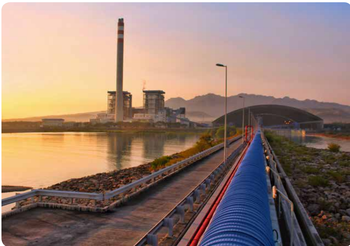
PLTU Rembang Rembang CFPP
